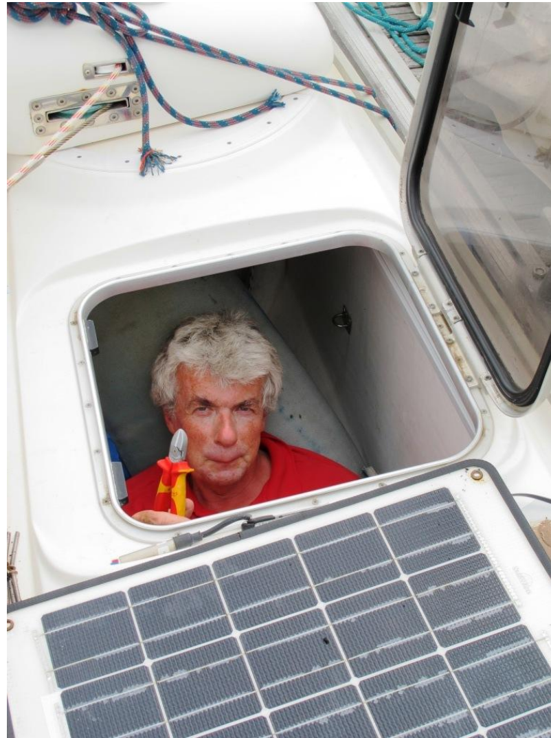
Dieter in einem der Schwimmer bei der Demontage der restlichen alten, sich delaminierenden (Dieters Präzisierung) Solarzellen.
